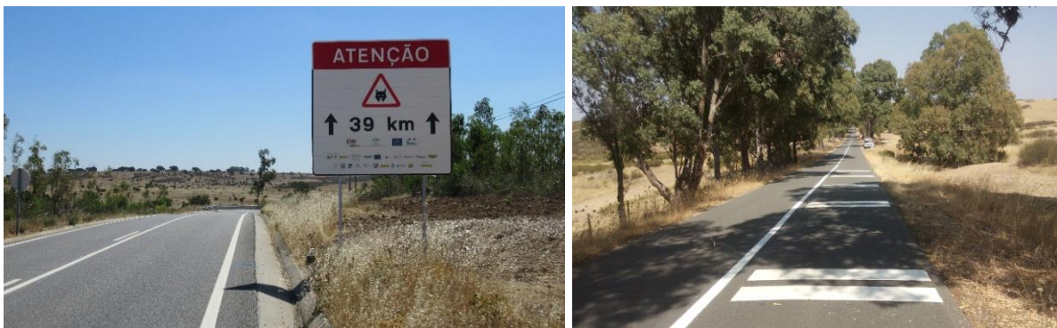
Fig. 30 – Sinalização avisadora de perigo, específica do lince-ibérico (esquerda) e bandas cromáticas redutoras de velocidade (direita) instaladas na EN122.
