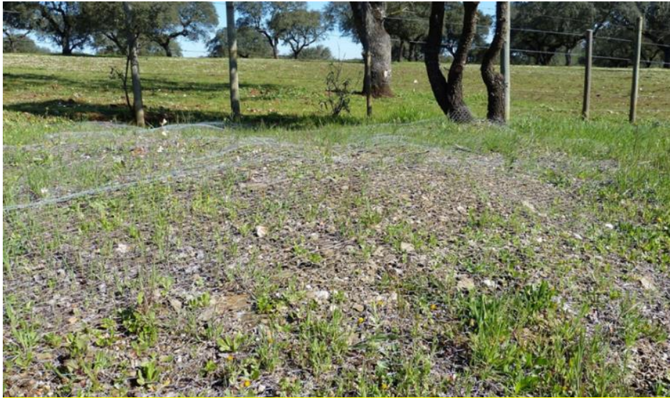
Fig. 33 – Colocação de rede sobre os taludes da EN4, com o objetivo de impedir a sua colonização por coelhos.
