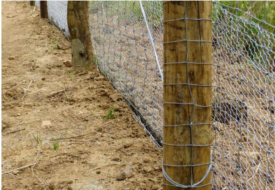
Fig. 35 – Rede adicional, de malha apertada acoplada à vedação principal, disposta em “L”, com uma base de 50 cm enterrada.
