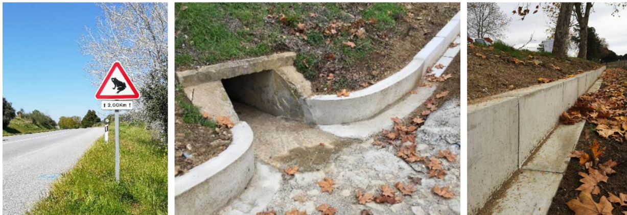
Fig. 32 – Sinalização vertical específica para anfíbios, criada no âmbito do Projeto LIFE LINES (à esquerda) e barreiras de encaminhamento de anfíbios para PH (ao centro e à direita).
