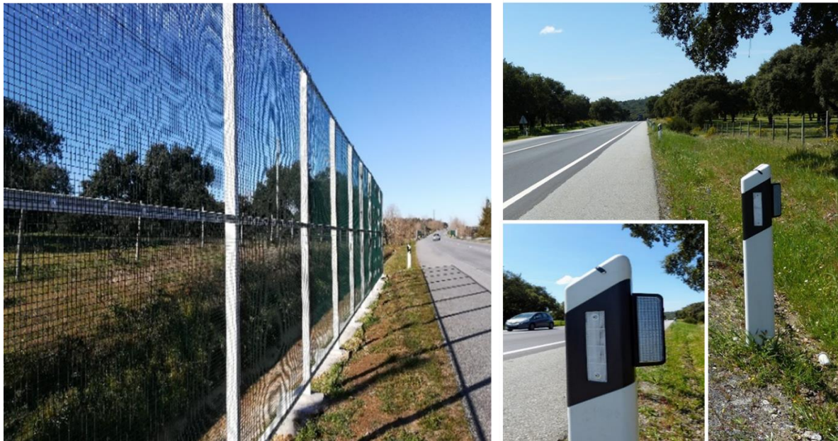
Fig. 34 – Barreiras para elevar e encaminhar o voo de corujas (à esquerda) e refletores específicos para refletir a luz dos faróis para a envolvente da via e alertar os animais de forma mais eficiente (à direita)
