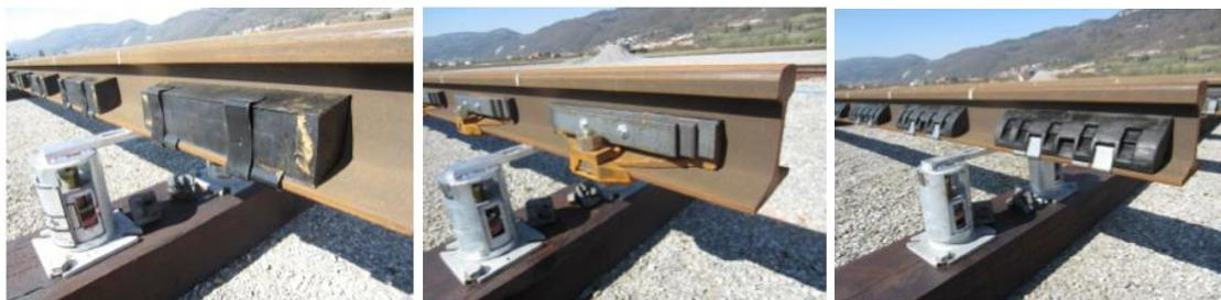
Figura 12. Atenuadores sintonizados de carril (TRD); esq. TATA/Corus, centro Schrey & Veit, direita STRAILastic\_A.
