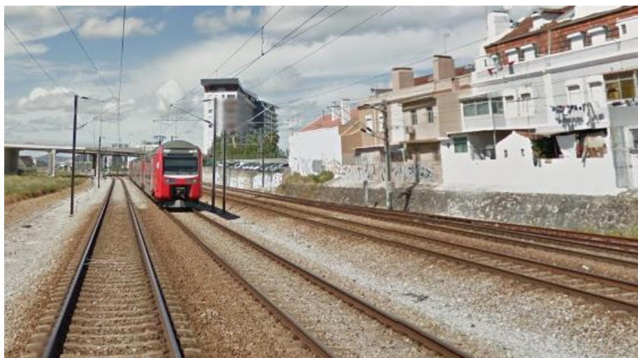
Figura 27. Edifício na proximidade da linha, na zona de Braço de Prata (lado descendente). Na imagem pode-se também observar uma composição UQE 3500 (fonte: google maps).
