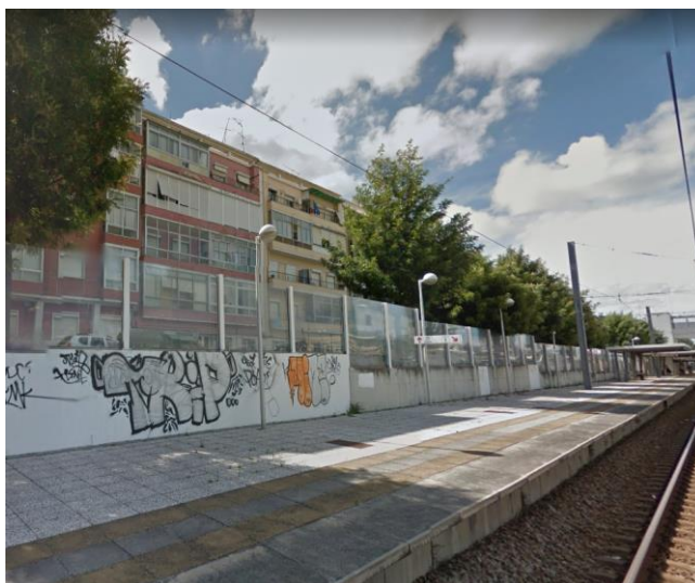
Figura 26. Barreira Acústica na Estação de Moscavide, sentido ascendente.
